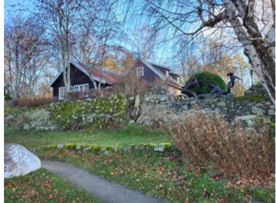
Bostadshusets fasader mot nordväst med murar och del av gångväg upp till tomten.
