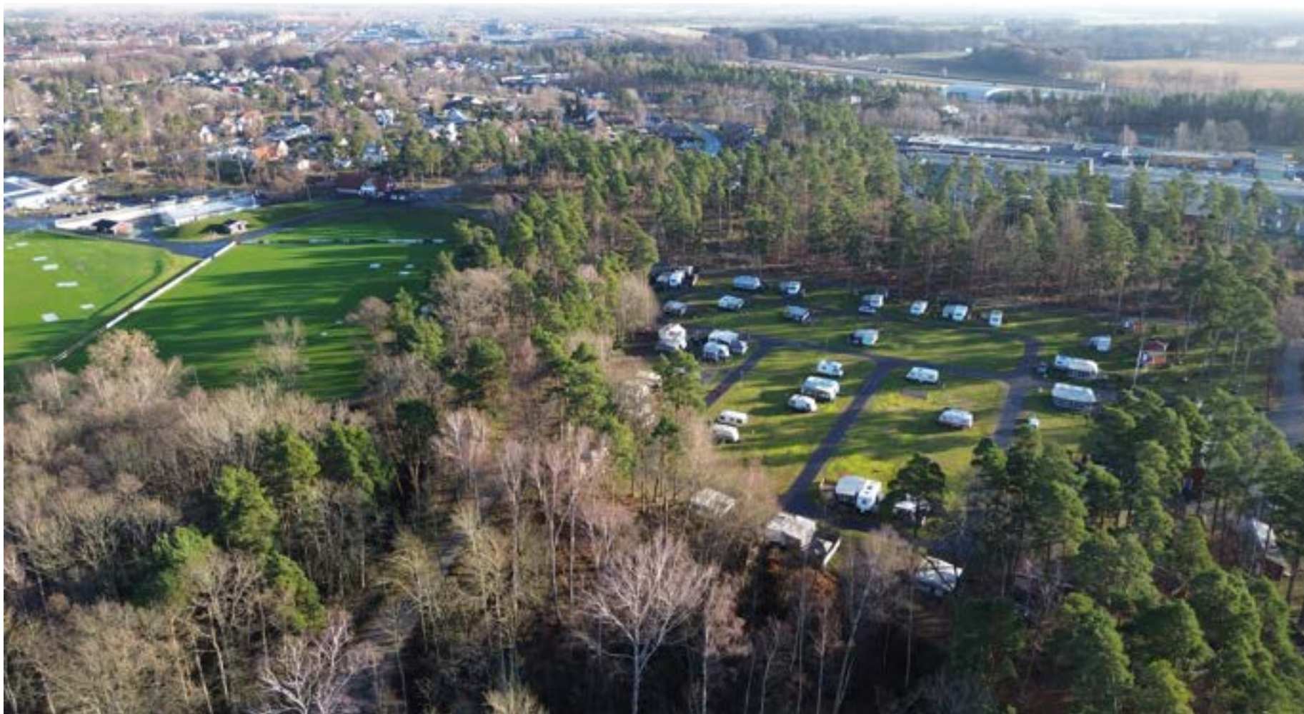
Flygvy över del av närområdet med campingen till höger och idrottsplatsen till vänster, omgärdade av strandskogens vegetation. Villabebyggelsen i södra utkanten av samhället syns uppe till vänster i bild.
