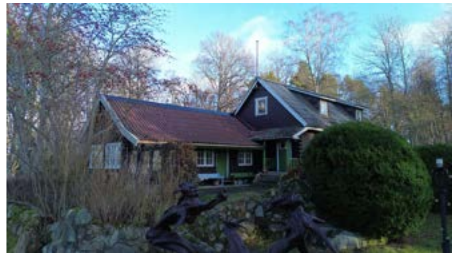
Vy mot entréer i söder.
