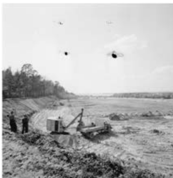
Planering av Strandängens idrottsplats år 1958. Foto: Egon Jönsson
