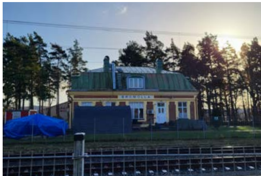
Den tidigare stationsbyggnaden, belägen på andra sidan spåren ungefär i linje med Bangårdsgatans sträckning mot stranden.
