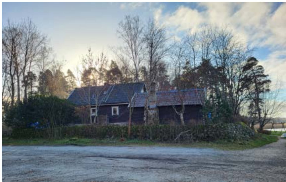
Vy mot fastigheten från Strandängsvägen i norr.
