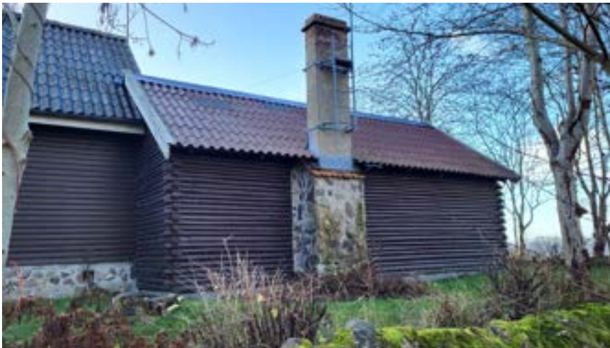
Mindre delen av bostadshuset, fasad mot Strandängsvägen med kraftig murstock och skorsten.
